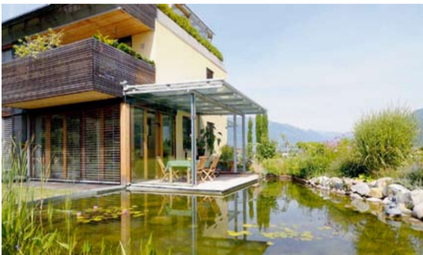
L'edificio Von Spinn a Lana (Bolzano), un esempio di architettura solare: costruito con materiali naturali, sono stati tenuti in considerazione il riciclo dell'acqua e l'utilizzo di fonti rinnovabili
