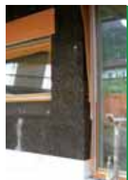
Il cappotto termico posato su tutto il perimetro della casa
