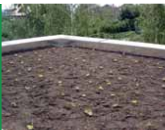
Il tetto verde per una maggiore protezione dal caldo
