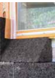
il cappotto risvoltato sulle finestre a evitare spifferi e muffe
